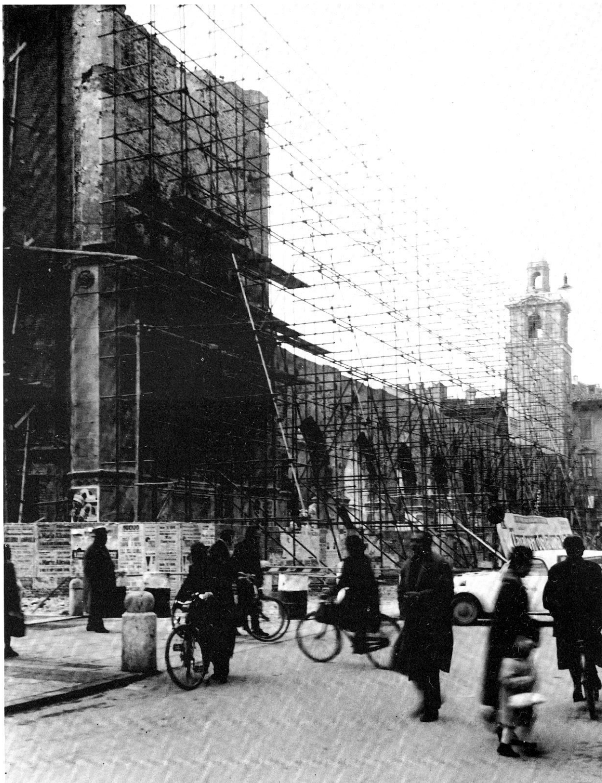
Demolizione del Palazzo della Ragione, metà degli anni Cinquanta.
