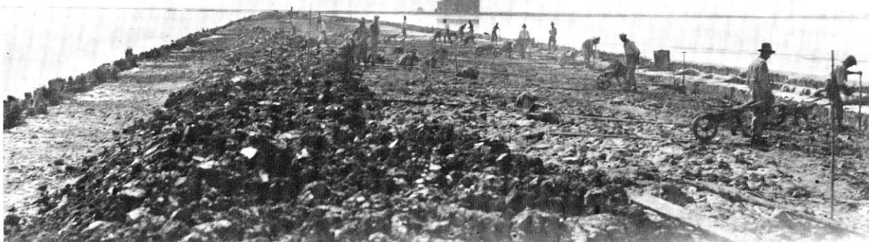
Bonifica della valle Isola e valli di Comacchio (costruzione di un argine).
