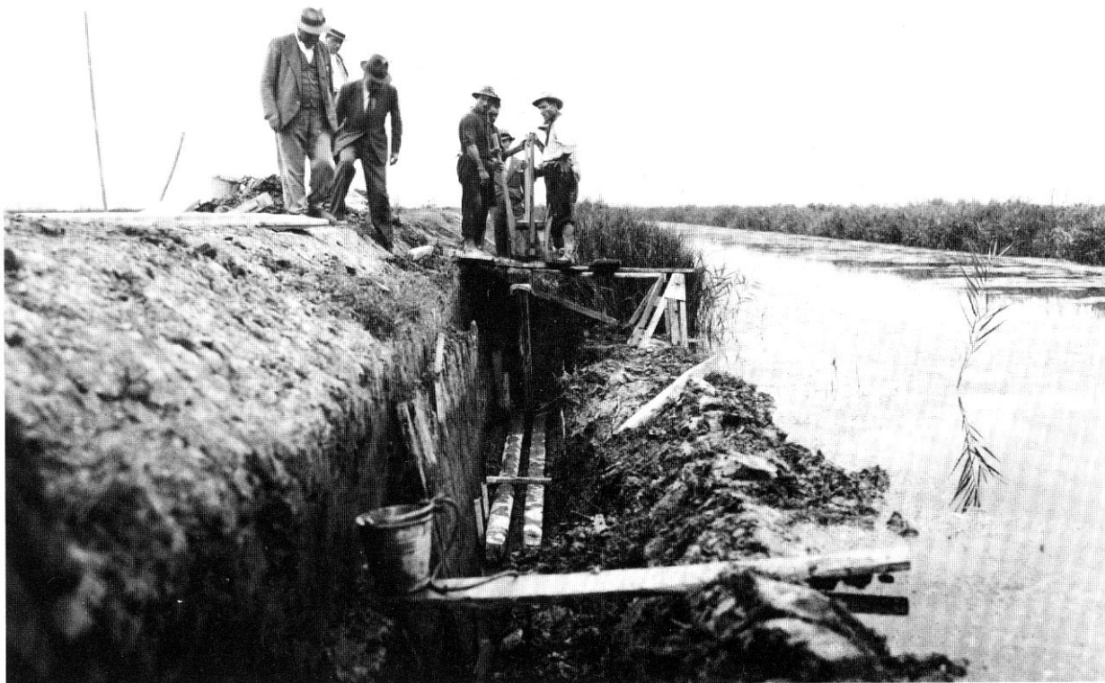
Mezzano, febbraio 1932: ripresa di una frana con pali.
