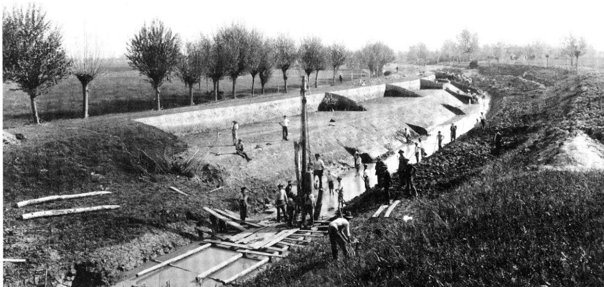
Fossalta, giugno 1931: operazione di tamponamento dell'acqua (cavedone).
