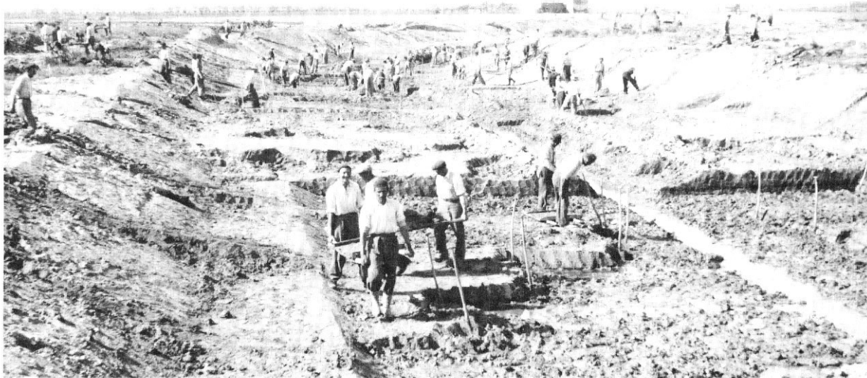
Valle Isola, lavori di bonifica. Escavo letto di un canale.
