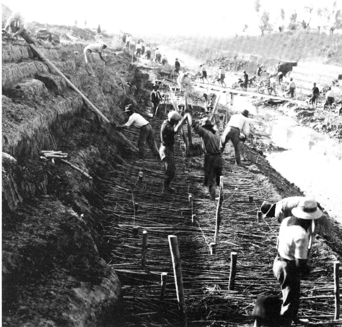
Labbiosola, 7 maggio 1934: frana in destra presso lo stabilimento Labbiosola vista durante la costruzione del terzo piano morto.
