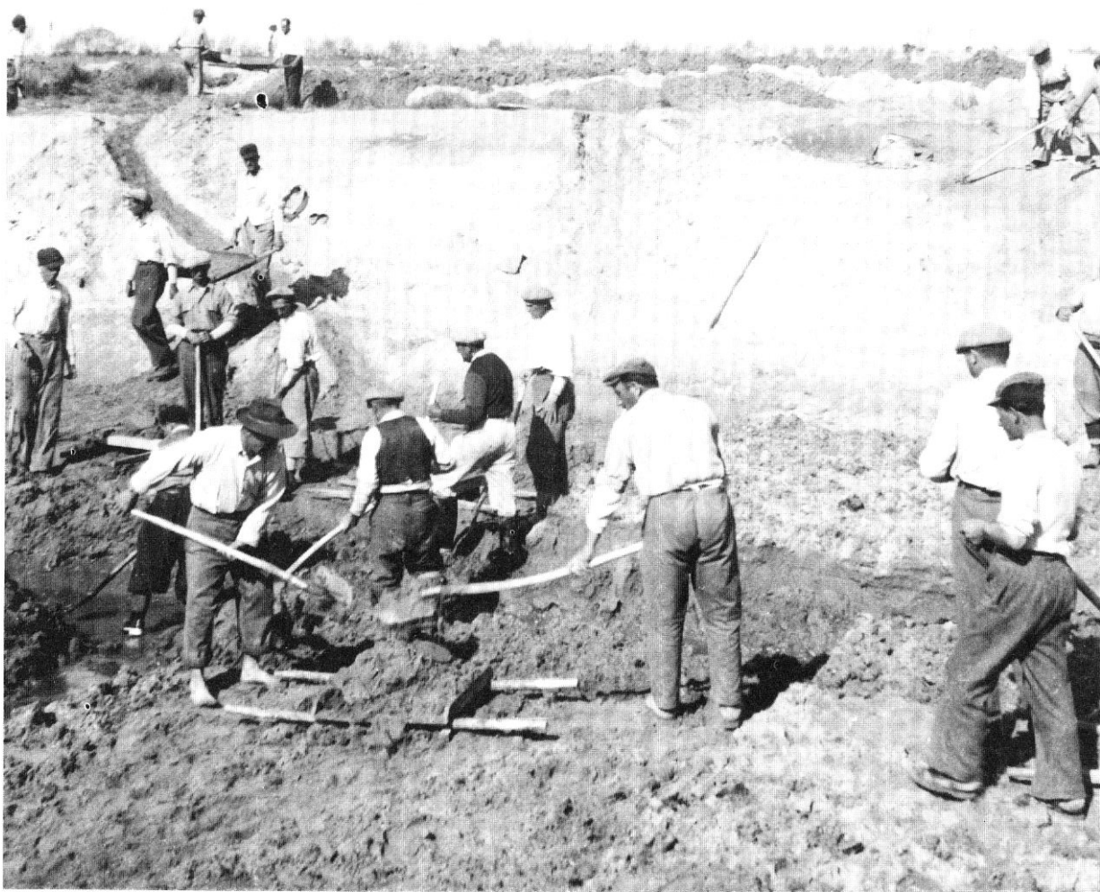
Valle Isola, lavori di bonifica. Escavo letto di un canale.
